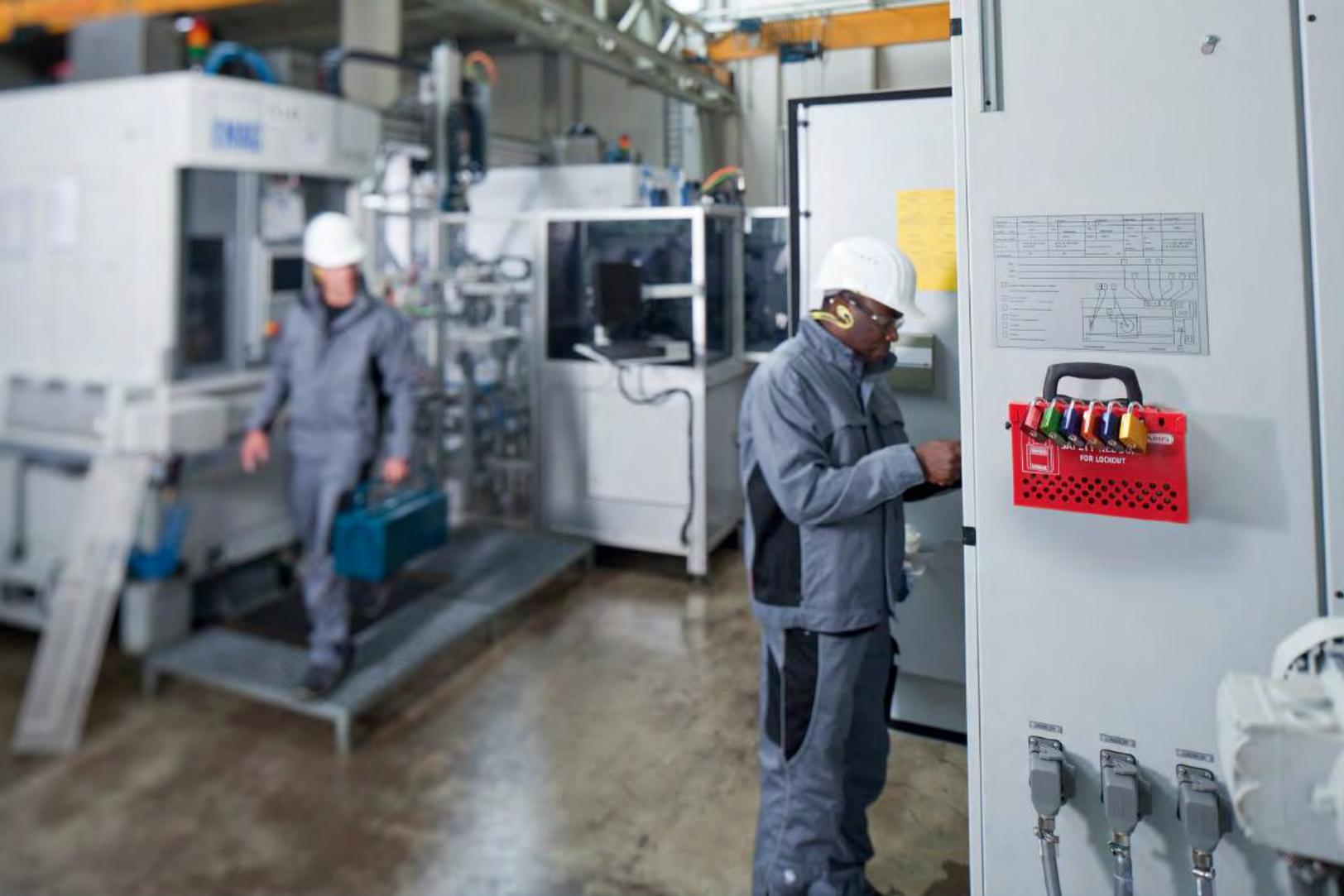
**Lockout-Tagout** | Lockout-Tagout oder LOTO ist ein Verfahren, bei dem Sicherheitsschlösser, Verriegelungen (Lock-Outs) und Sicherheitsanhänger (Tag-Outs) für ein sicheres und spannungsfreies Arbeiten an Maschinen oder Prozessen verwendet werden. Alle Energiequellen werden vor Arbeitsbeginn isoliert, verriegelt und mit einem Tag versehen.
